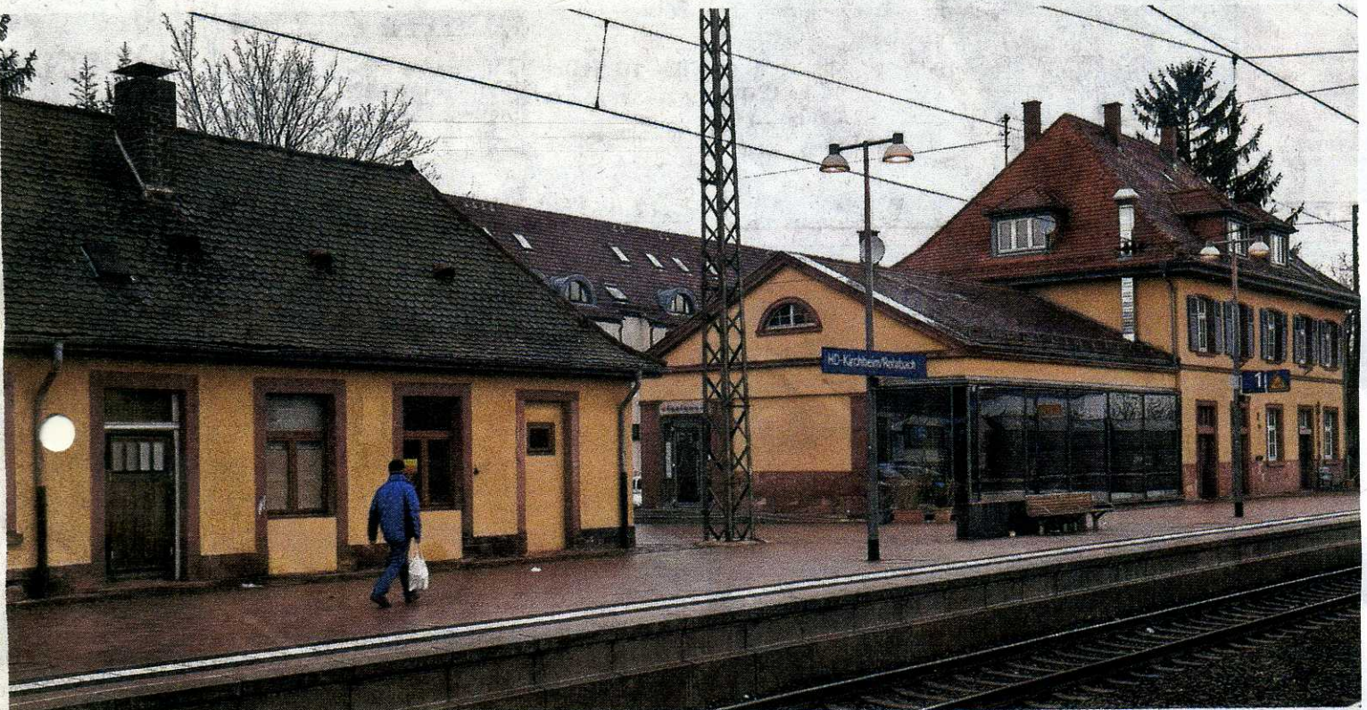
Seit drei Jahren existiert das Beschäftigungs-Projekt „Stazione“ (rechts) am Kirchheimer Bahnhof. Es gibt ehemals Drogenabhängigen die Möglichkeit, sich auf eine ins Berufsleben vorzubereiten. Weil EU-Gelder fehlen, hoffen die Verantwortlichen auf kommunale Unterstützung.
